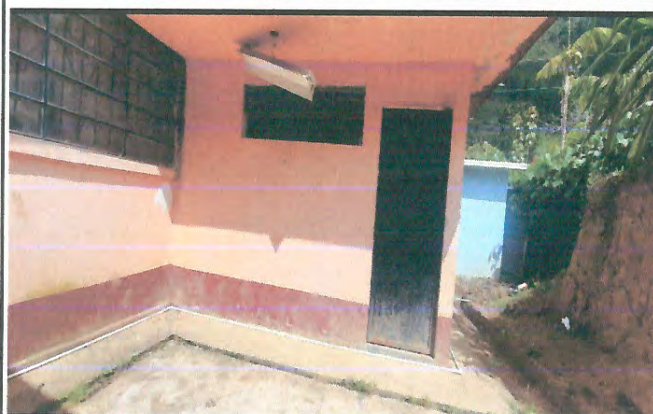
Foto 3: Mejoramiento y ampliación de servicios sanitarios
