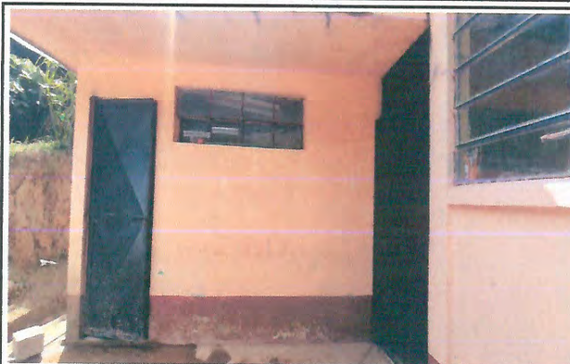
Foto 2: Mejoramiento y ampliación de servicios sanitarios
